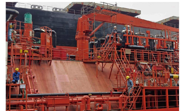
“安全随手拍”——设备维护保养
