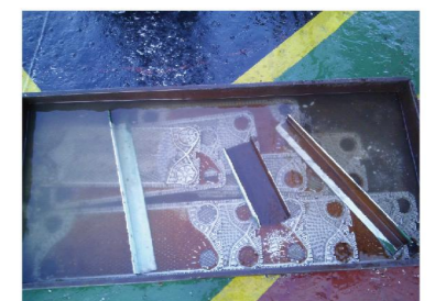
招商南油造水机热交换器维护
