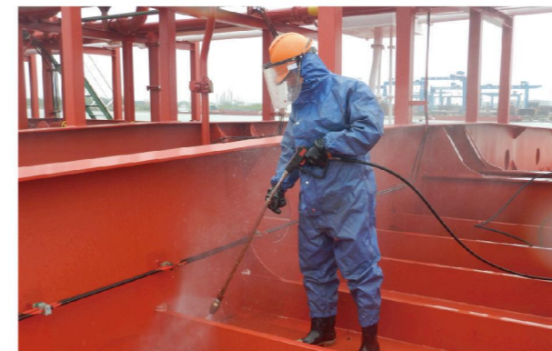
“安全随手拍”——设备维护保养
