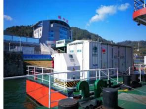
可提供 12 个泊位待航船舶供电容量共计 7,500 千伏安的岸电负荷，能同时为 6 艘趸船、12 艘大型豪华游轮提供岸电。 |
