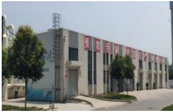
图：污水处理站
