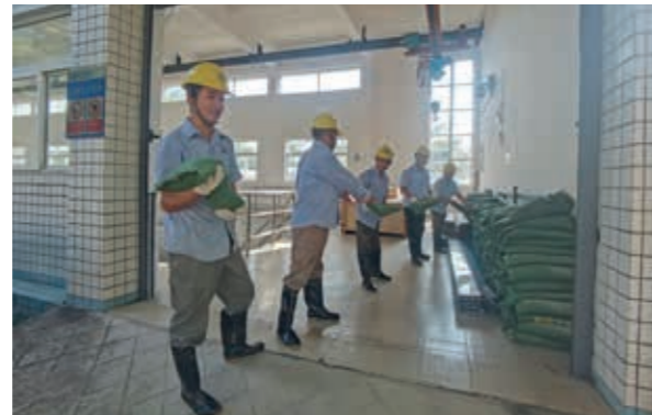
深圳市大工業區水務有限公司落實水廠泵站防洪措施
