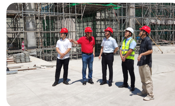
▲ 天禾股份领导对在建项目进行安全检查
