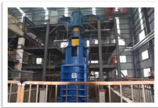
图：金安矿业超纯铁精粉项目现场
