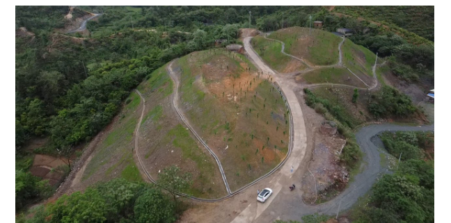
水口山有限康家湾矿 1 号废石堆场修复治理后复绿
