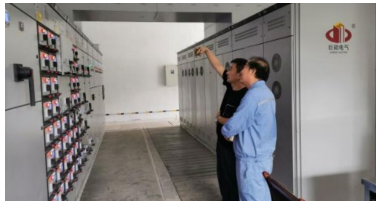
车间运维检修
