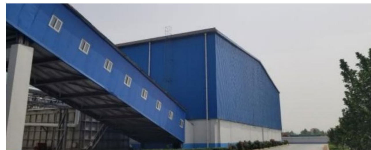
密闭储煤棚及输煤栈道
