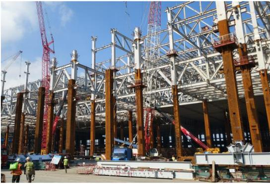
图 5：NCC 钢结构应用于大型工业厂房
