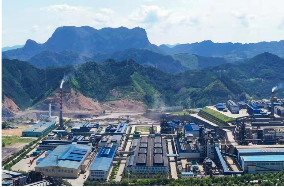
铅锑银多金属物料协同冶炼及综合回收关键技术及装备
