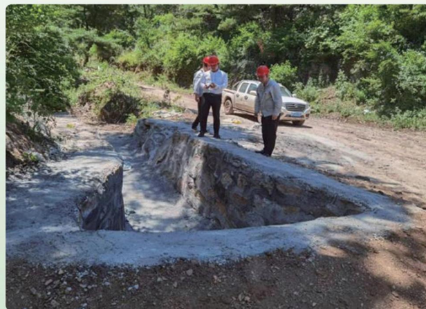
道路增加涵管后的巡检
