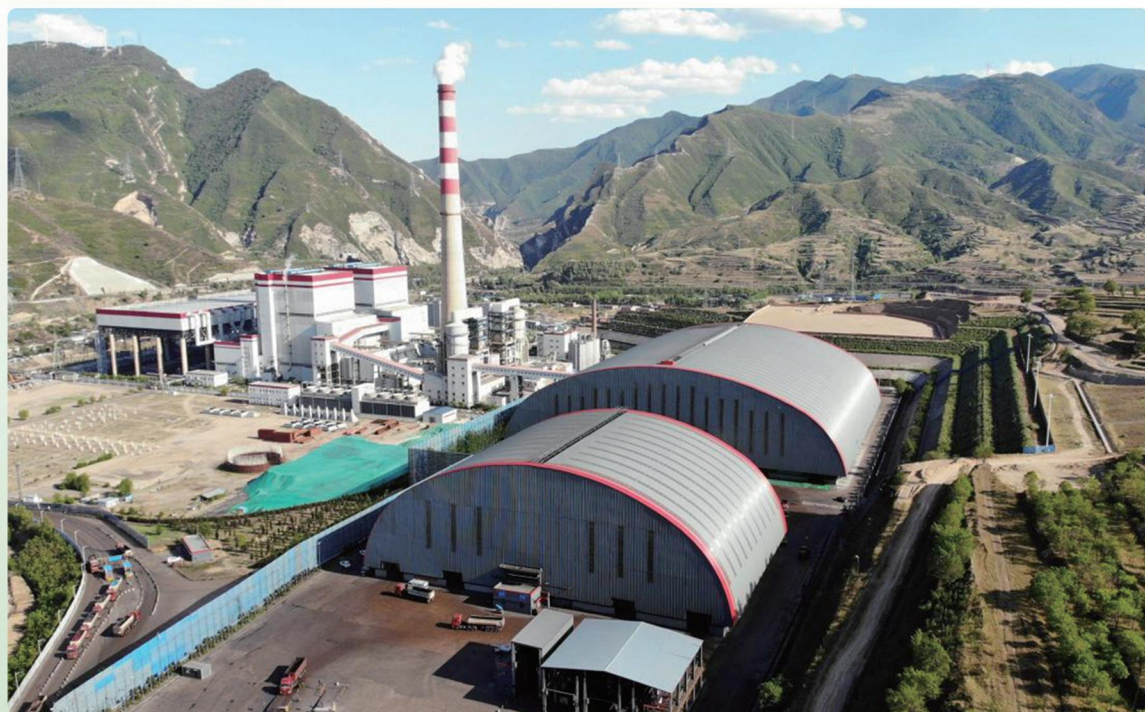
图为同华发电公司封闭煤场鸟瞰图
