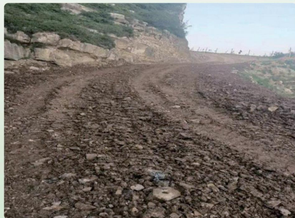
道路及排水渠修整后
