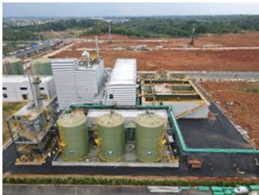
湖南某银粉废水项目
