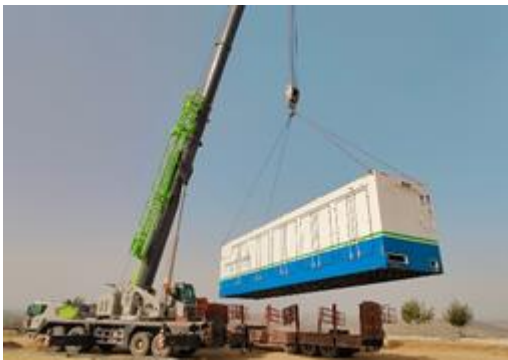
甘肃某油田压裂返排液废水处理项目——集装箱可移动式成套设备产品
