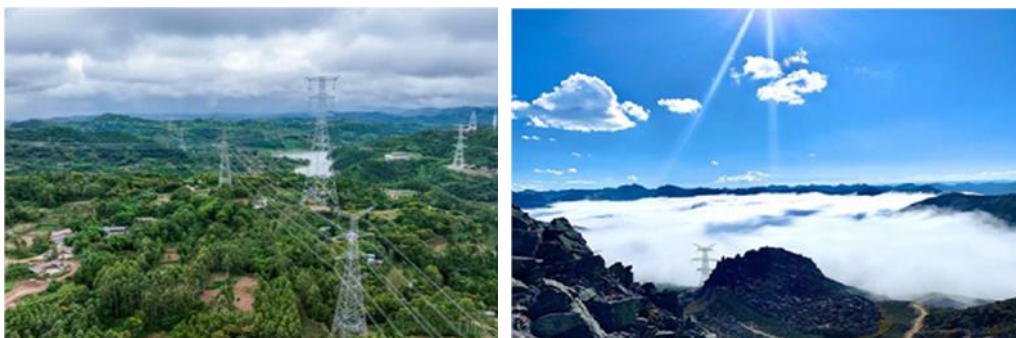
图：川渝 1000kV 特高压交流工程
