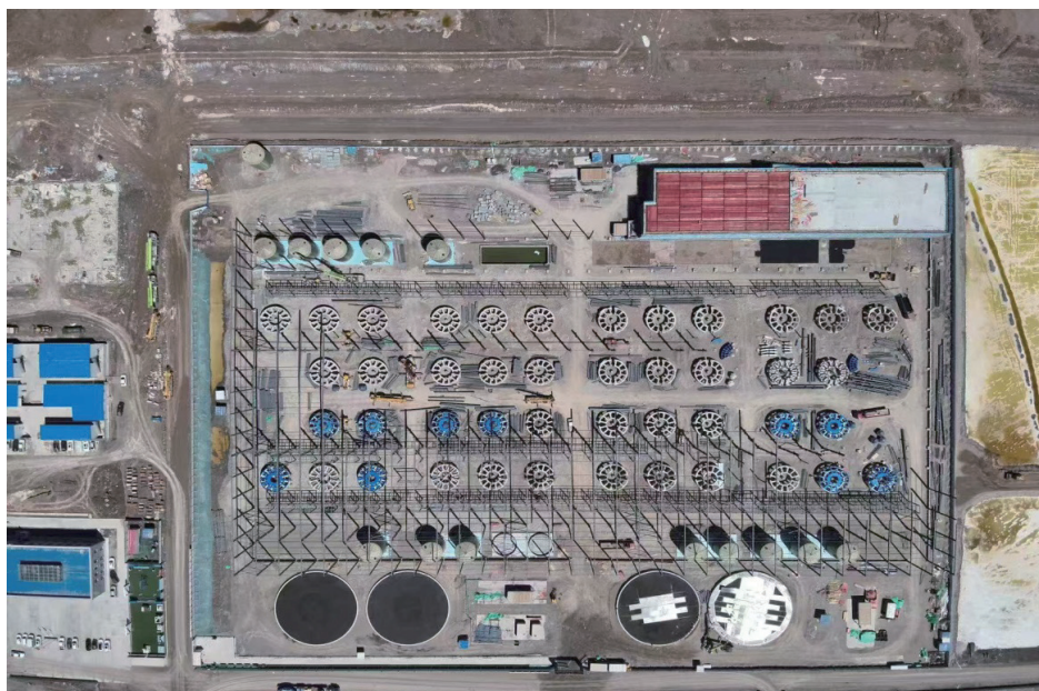
公司4万吨基础锂盐项目施工现场图
