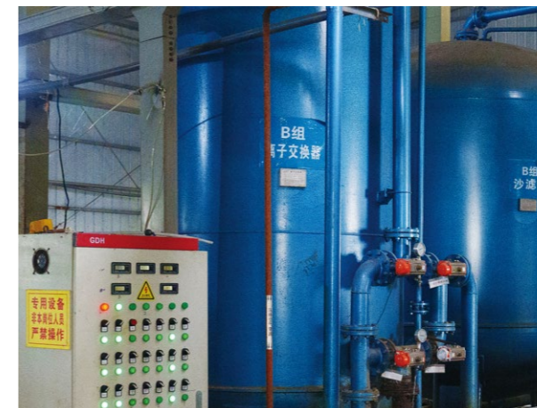
净水、软水、废水处理装置
