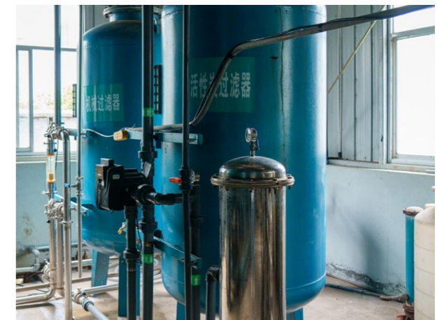
净水、软水、废水处理装置
