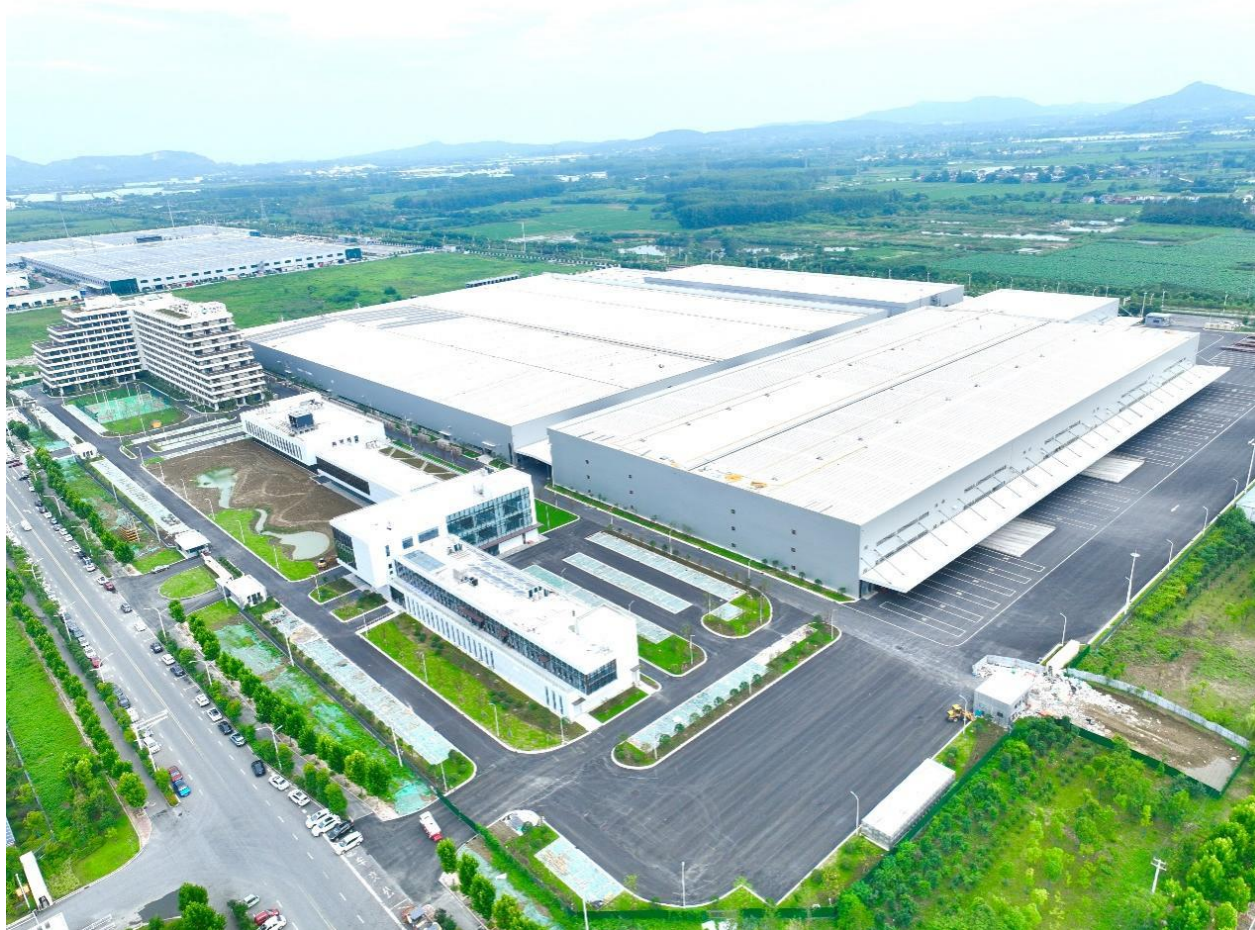
图片来源：合肥组件基地二期工厂航拍实景图
