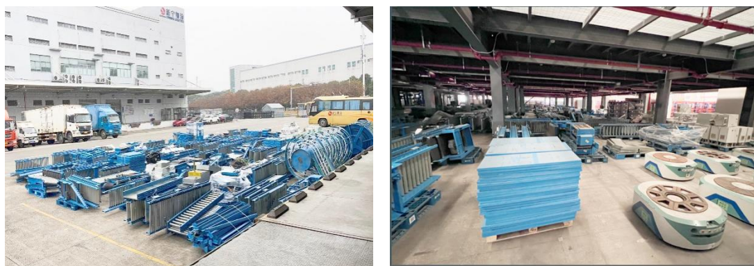
昆山仓库拆除部分的实景图（摄于 2023 年 12 月）
