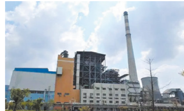
大型煤电机组大比例掺氨燃烧示范工程
