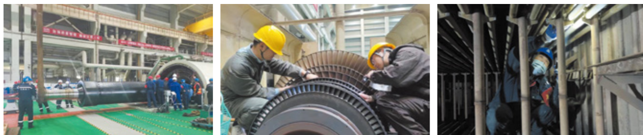
皖能铜陵公司“五一”保供检查检修工作
