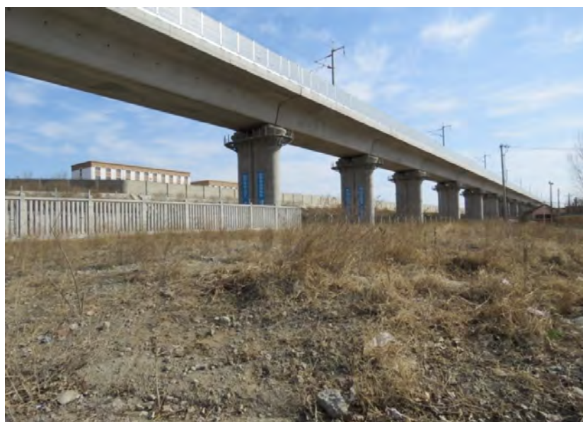
图 6-1-25 本项目主线下穿济青高铁
