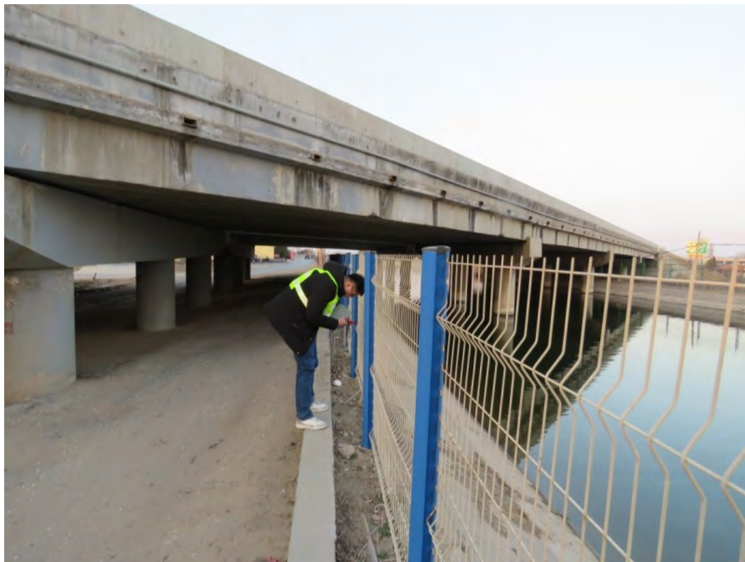
图 6-8-3 寒亭总干渠现场图
