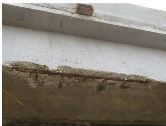
图 4-6-4 锈胀露筋
