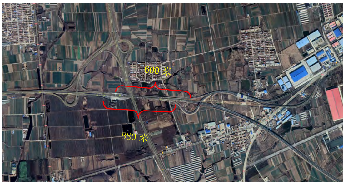
图 莱西北-冯格庄互通立交现状
