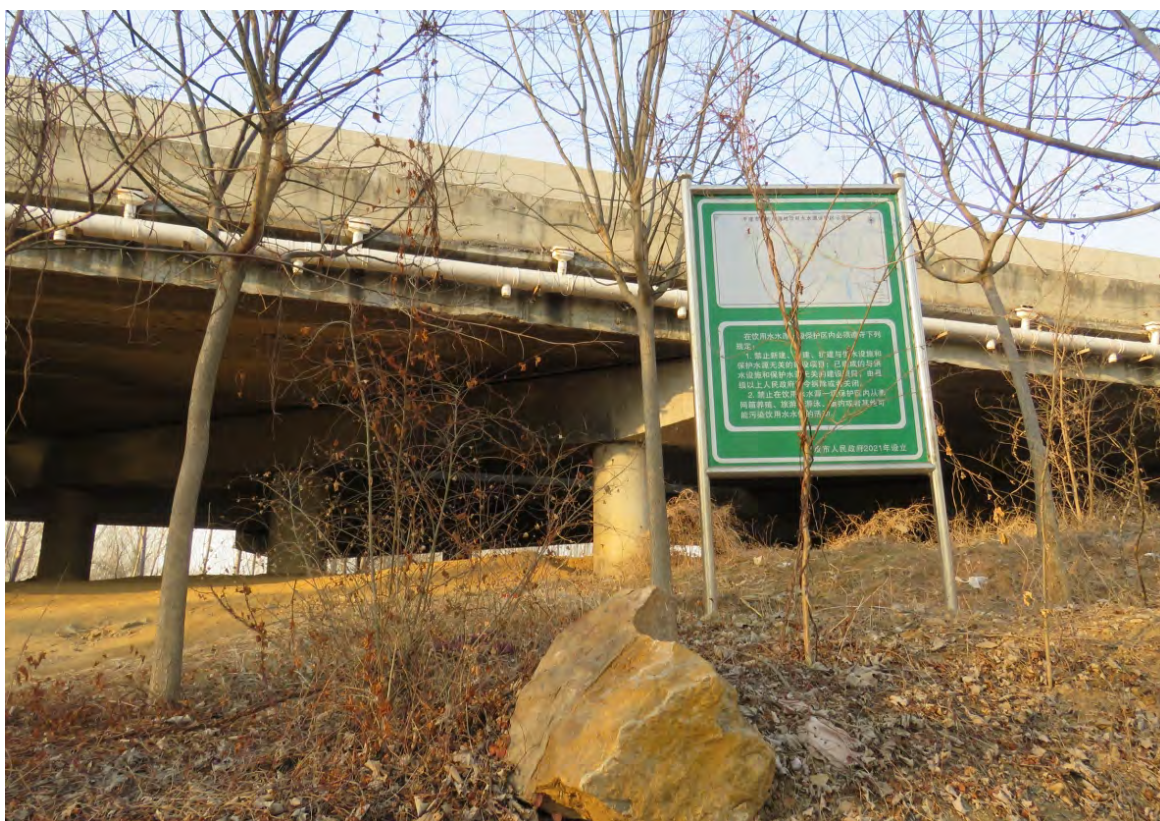
图 6-1-19 云山丈岭地下水源地一级保护区保护牌
