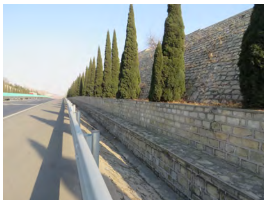
图 4-5-4 挖方浆砌片石防护
