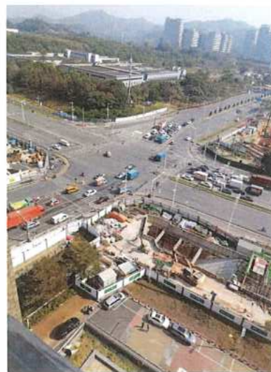
临路状况（地铁站施工中）
