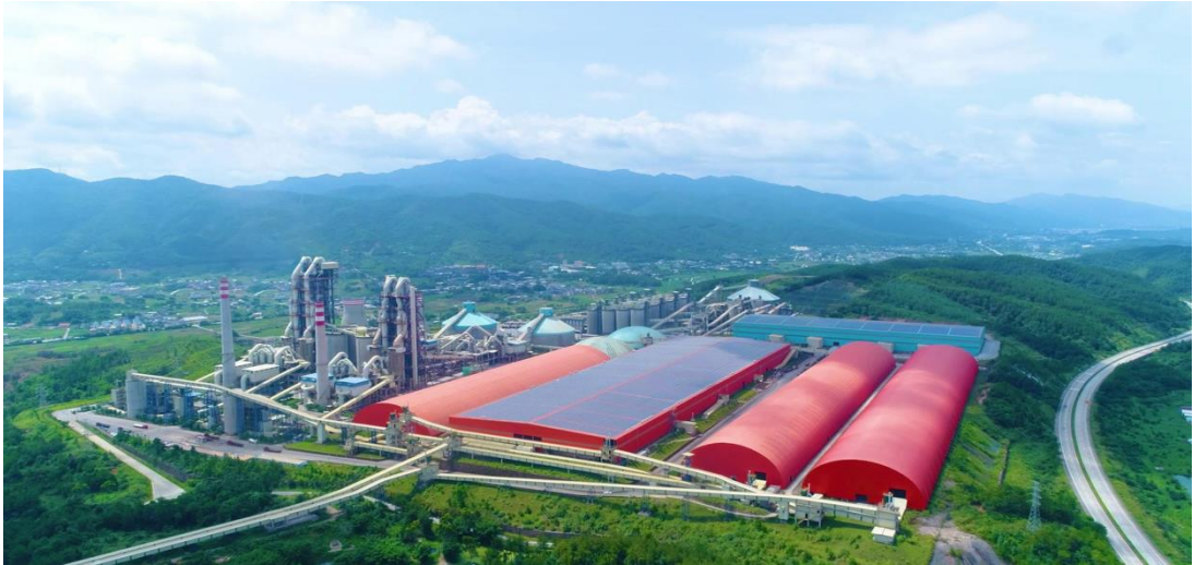
（塔牌集团 2 条 10,000t/d 新型干法旋窑水泥生产线项目全景）
