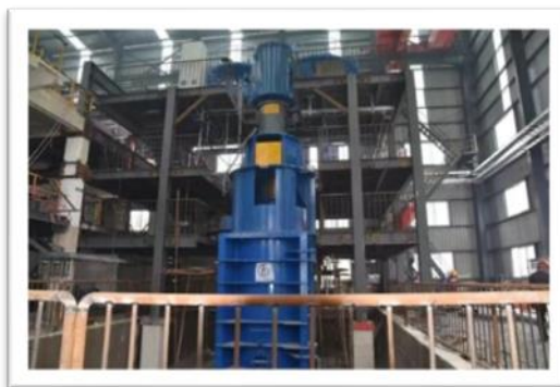
图：金安矿业超纯铁精粉项目现场
