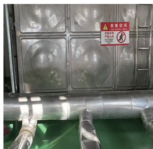
废水冲厕改造
