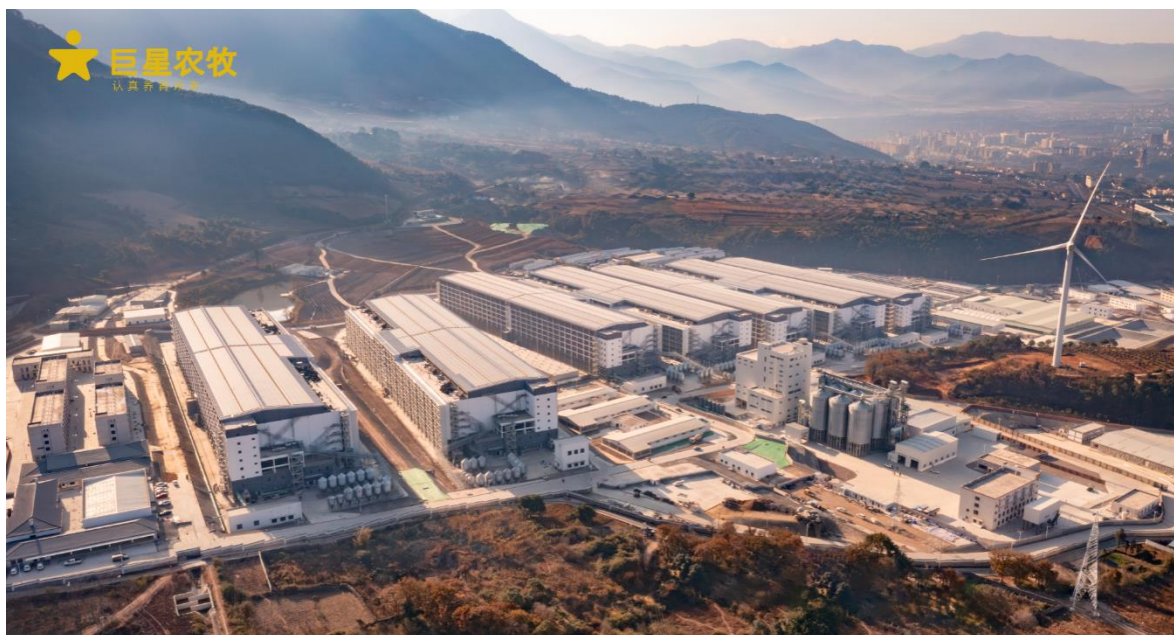
图 2：巨星农牧现代化楼房猪场
