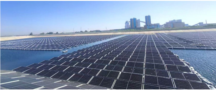
西北公司母杜柴登矿井光伏项目
