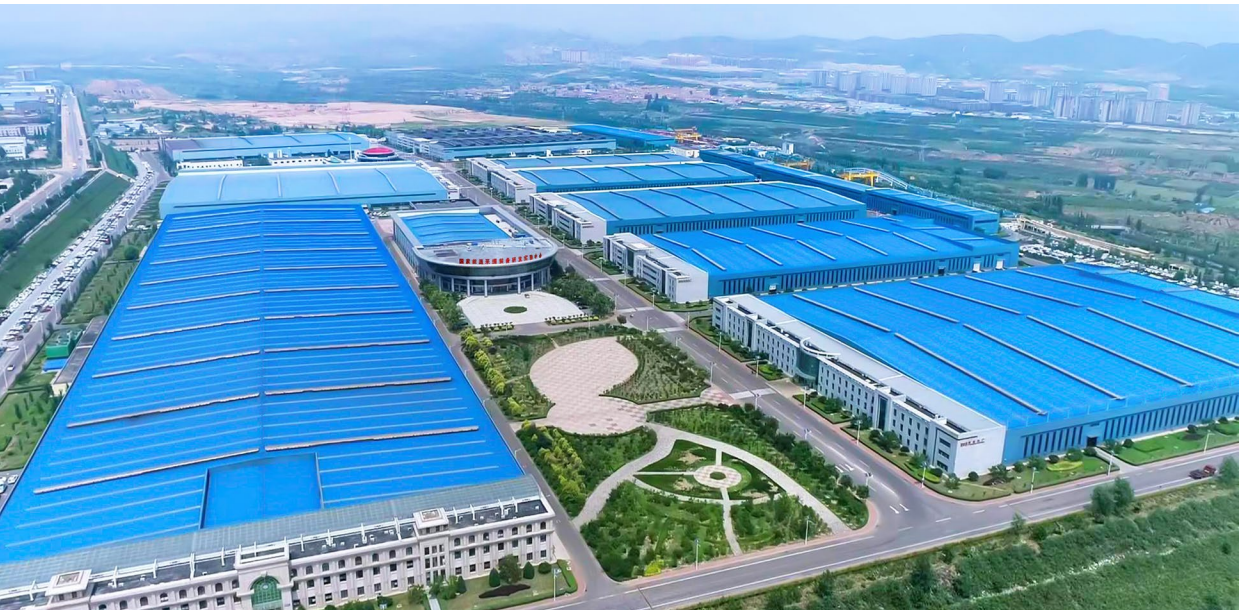
煤炭行业首个“绿色工厂”——北煤机公司
