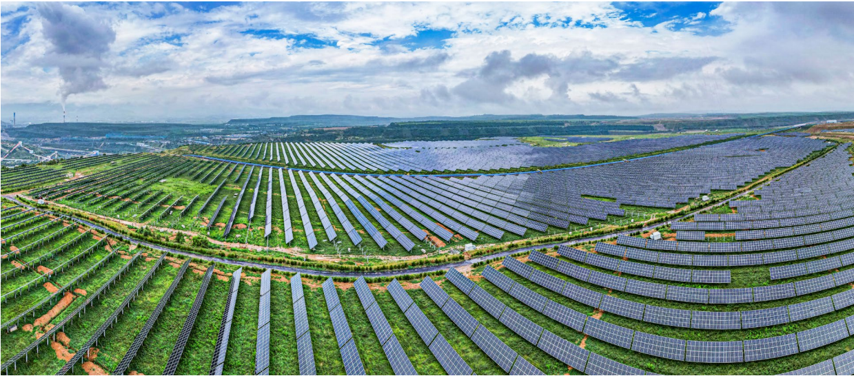
平朔集团 100 兆瓦光伏项目
