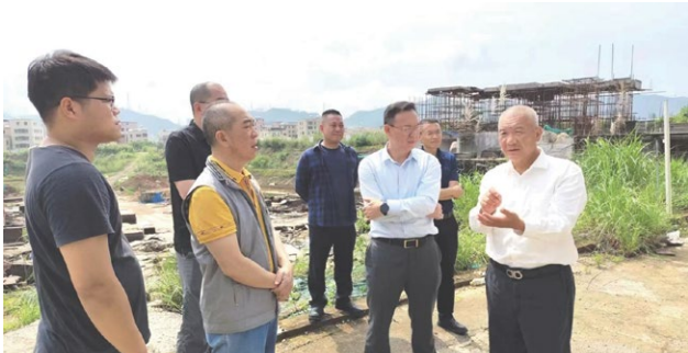
深房林馨苑停建工地安全检查
