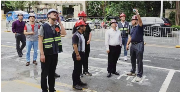
光明里项目在建工地安全检查
