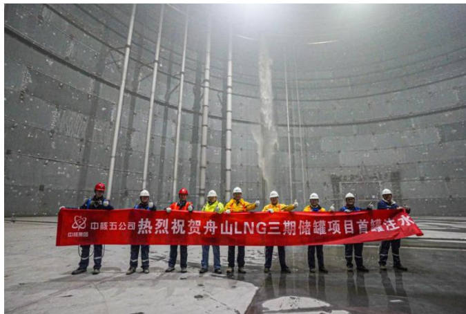
舟山接收站三期项目首罐注水
