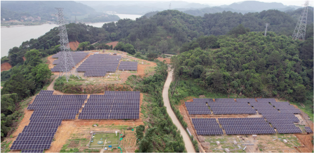
光伏发电项目现场
