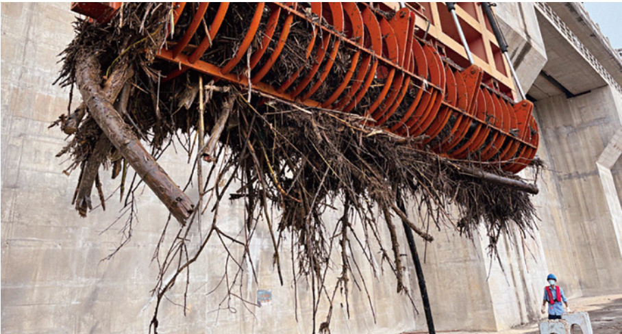
公司水电厂利用坝前拦污栅、清污机等设备处理坝前垃圾超 50 吨
