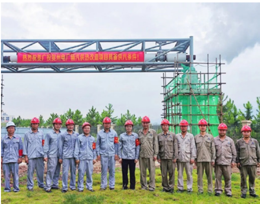
热电联产技改项目现场
