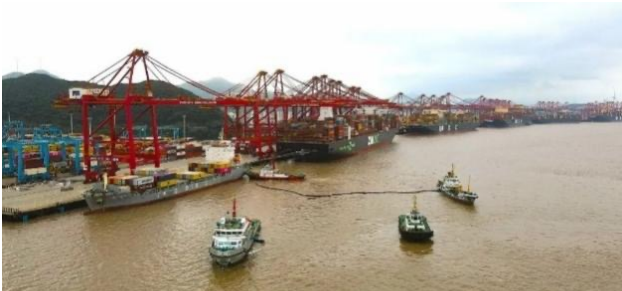
宁波港域联防体应急综合演练
