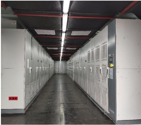
岸电中的变频设备
