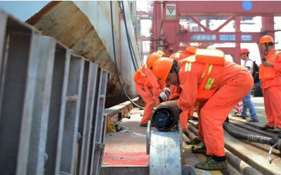
船舶靠岸使用岸电作业过程
