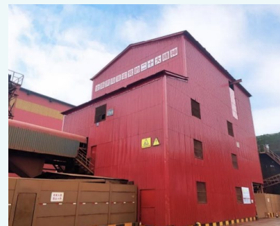
装车楼改造抑尘控制噪音
