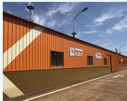
廊道改造，抑尘控制噪音
