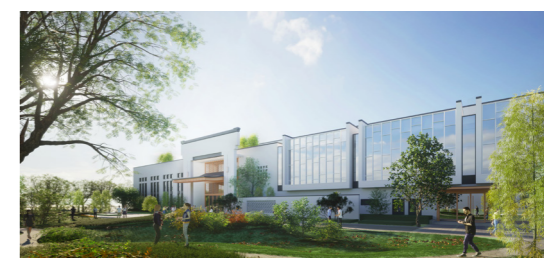
青浦区生物资源化利用中心项目
