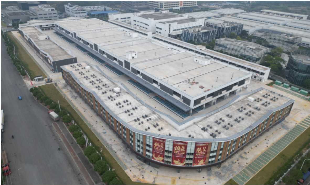
金桥保障房项目
