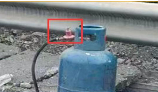
液化石油气软管长度超过 2 米
