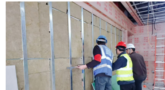
公司铺设隔音玻璃岩棉板
