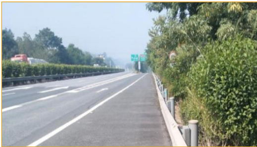
匝道出口限速牌被绿植遮挡
