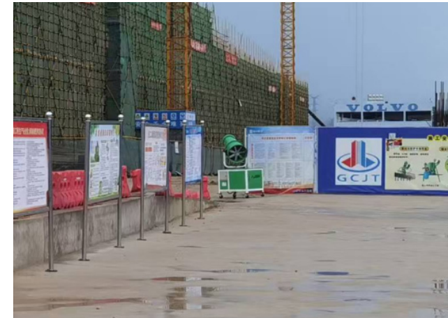
施工场地内采用雾炮机进行降尘处理
