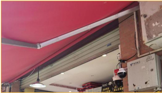
使用绝缘层与铁架隔离
