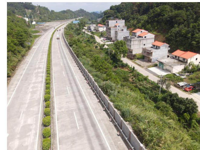
岑罗公司对其管辖路段增设隔音墙设施
