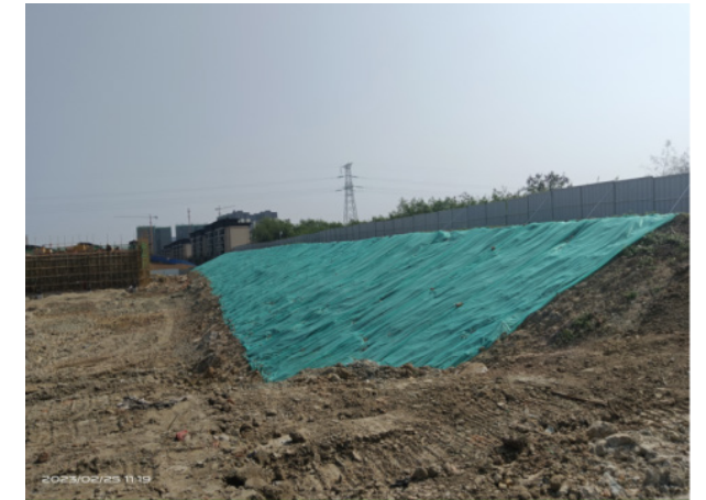
施工场内裸露土体部分采用防尘网进行覆盖，降低扬尘风险
