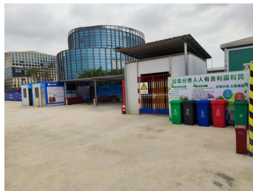
施工场地内采用垃圾分类处理
