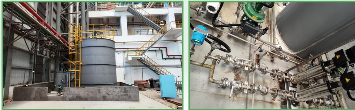
SNCR(液态高分子)脱硝系统提标改造
