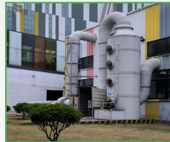
飞灰固化养护车间废气处理设备
