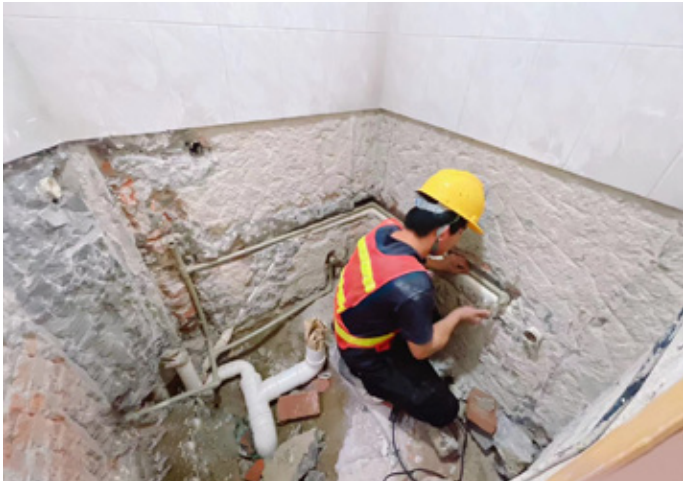
广州澳华达园区水管统一升级改造
