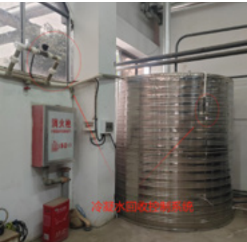
冷凝水回收控制系统
