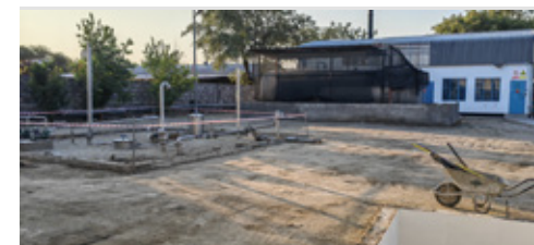
非洲厂改造前
