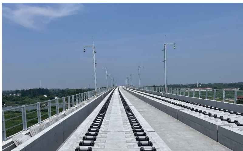
公司轨道扣件产品应用场景示意图 (沪苏湖高铁建设现场情况)
