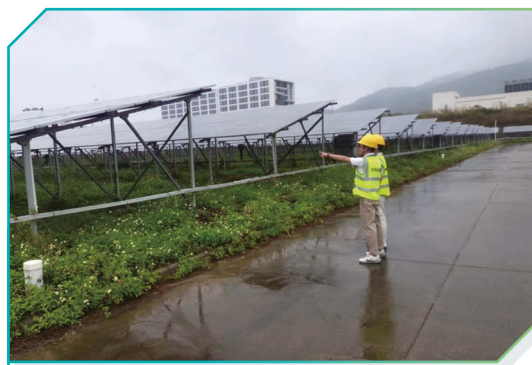
运维人员巡检维护2
