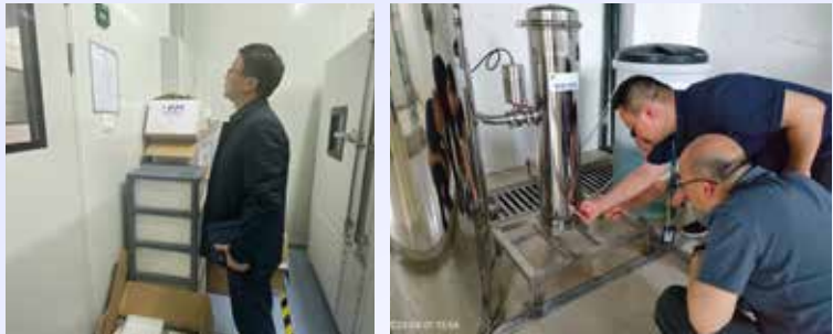
安全巡检现场图片
