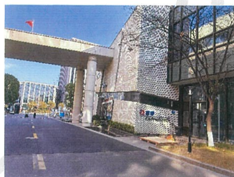
建筑物外立面
