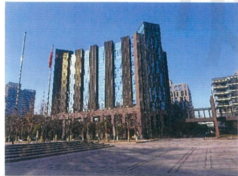
建筑物外立面
