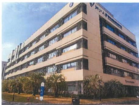
建筑物外立面
