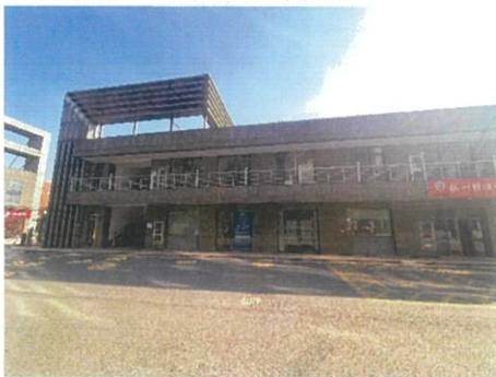
建筑物外立面
