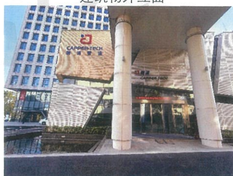
建筑物外立面
