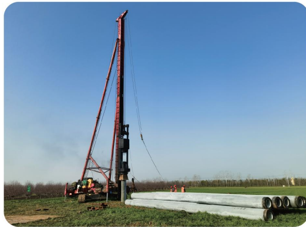
预制管桩施工现场
