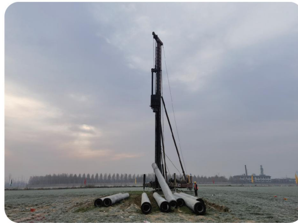
预制管桩施工现场
