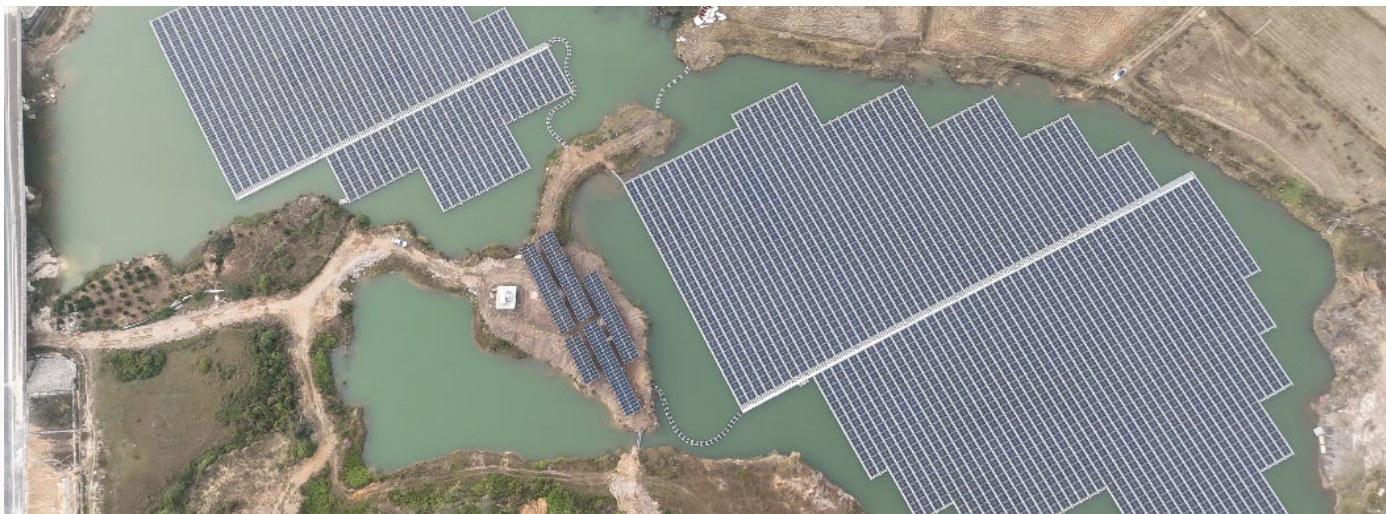
金盘科技甲子 100MW 农光互补光伏发电项目
