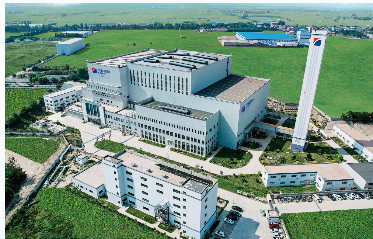
石家庄赵县生活垃圾焚烧发电项目
