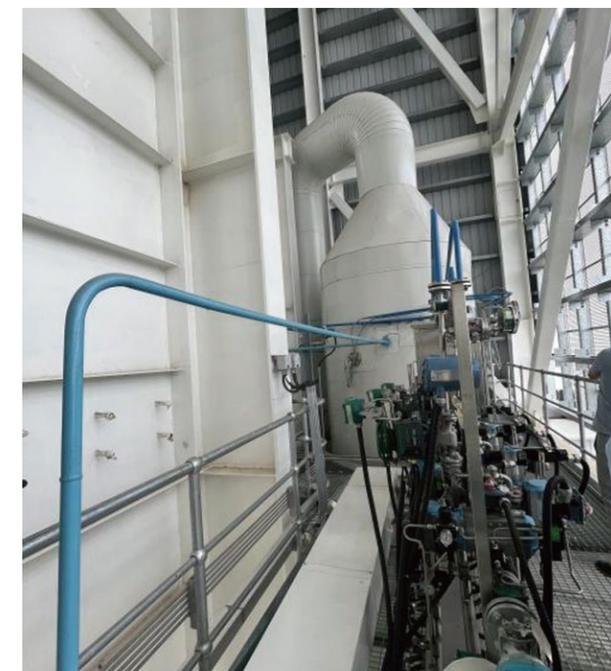
SCR 脱硝装置
