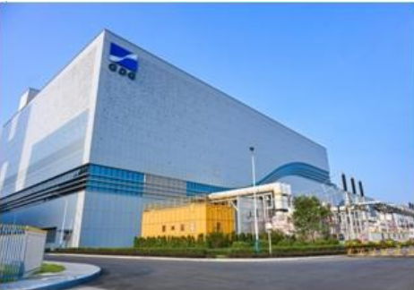
LNG 二期电厂主厂房
