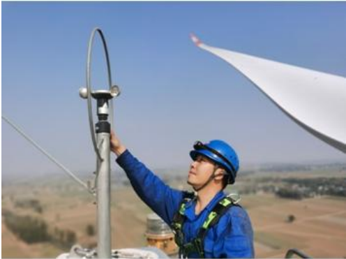
运维人员检查风机设备
