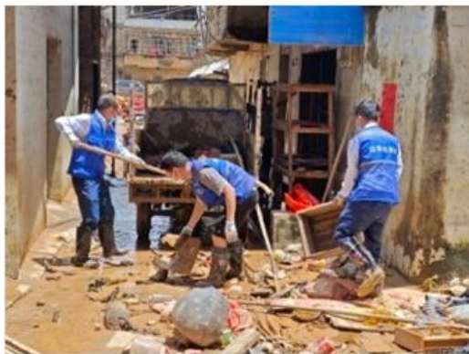
协助新铺镇抗洪救灾清淤现场
