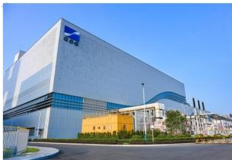
LNG 二期电厂主厂房
