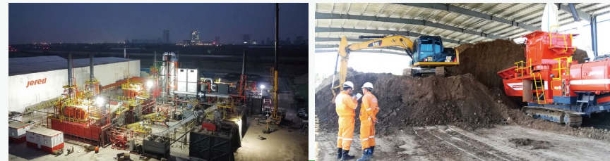
蓬莱化工片区重污染土壤修复现场
