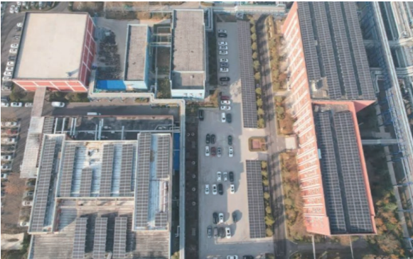
厂区光伏发电项目
