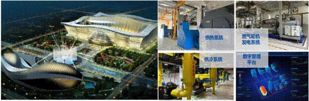
图 6：成都世纪新能源天然气冷热电三联供分布式能源项目
