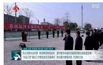
水运：主持设计的苏南运河无锡段航道“三改二”工程顺利开工
