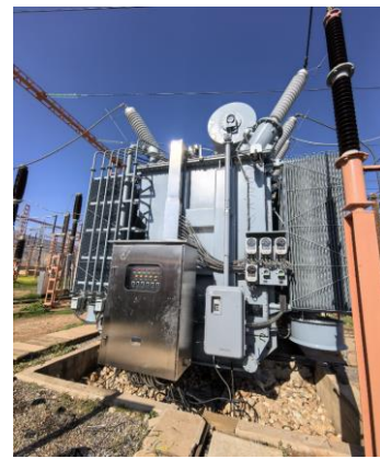
项目名称： 摩洛哥国网 变压器规格： 150MVA/220kV 开关型号： SHZVIII
