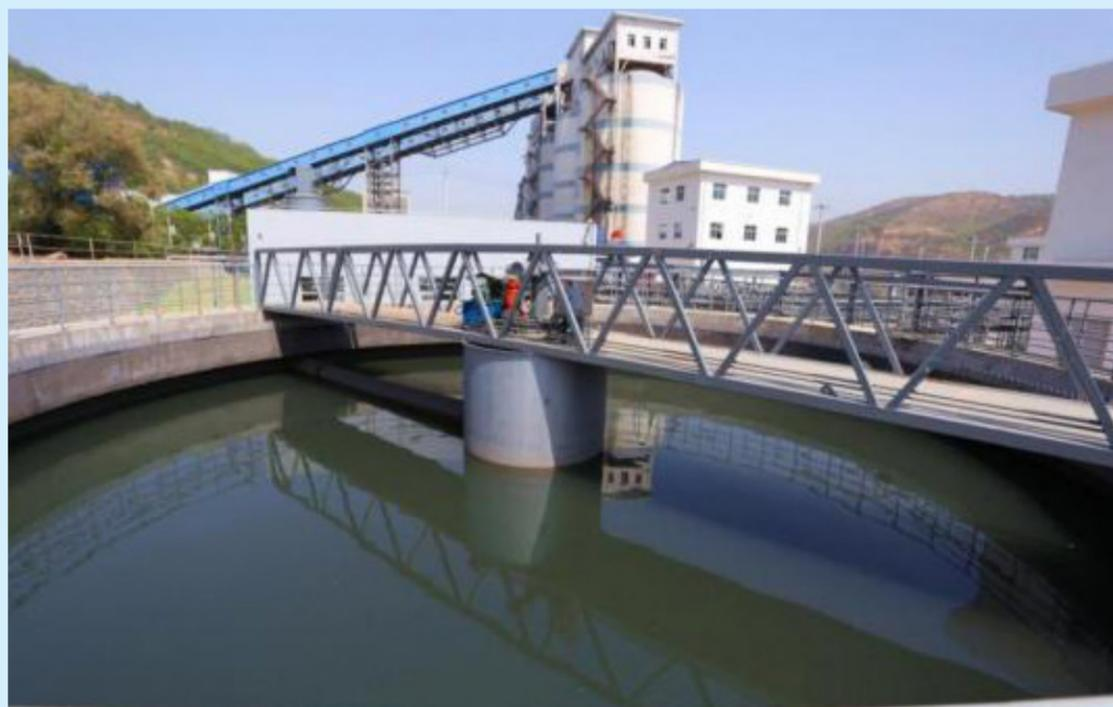
碧水源研发的以“多膜耦合 + 催化吸附”工艺为核心的矿井水回用技术，具有高效性、高再生性、高选择性等技术特点，使矿井水资源化利用的整体成本降低 20% 以上，使得矿井水变废为宝。
