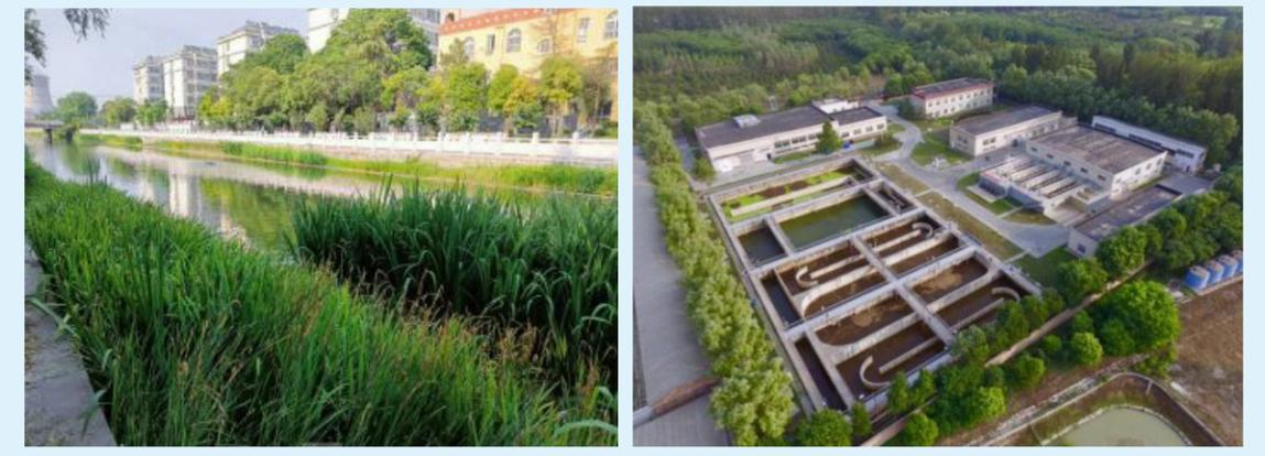
通过河道清淤疏浚、岸带修复、生态修复、景观绿化等一系列工程实现城市黑臭河道治理，重新构建河流生态系统平衡。应用“MBR-DF”双膜新水源技术，将出水提升到饮用水水源标准，可为翠湖湿地补水，具有补给水源地和保护水环境的双重功能。
