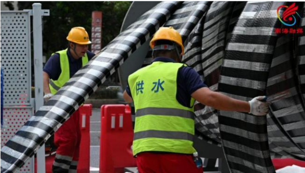
工作人员将复合软管拖入原有管道
